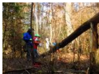
枯損木の除伐
