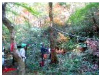
== 整備作業風景 ==
