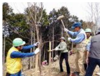
鳥居杭の打ち込み
