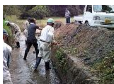
ジャブジャブ池の土砂上げ
