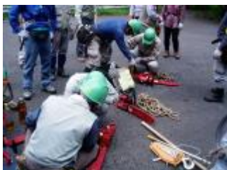
作業前の点検
